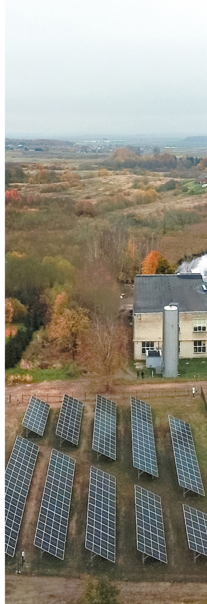
Gabriels delejede farveri, Scandye, har et solcelleanlæg med en beregnet årlig produktion på 396 MWh.
